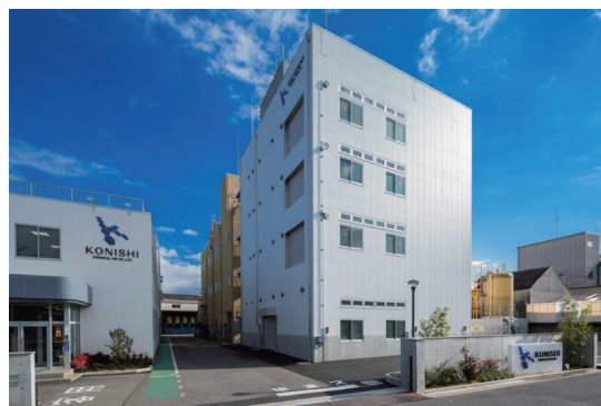
本社工場(左建物: 本社事務所, 中央手前建物: 新規開発プラント(2018年10月完成))
