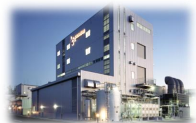
福井工場M2P('17.10竣工)
