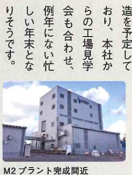
M2プラント完成間近
